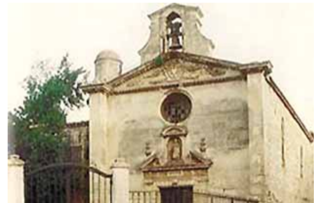
Façade de la chapelle des Pénitents Gris
